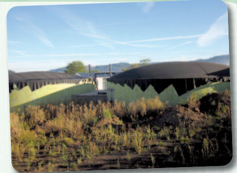
Digesteur vertical (cas 1 cf page suivante)
