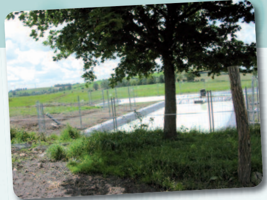
Décantation et pré-stockage avant épandage sur prairies
