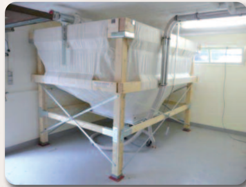
Silo textile de stockage de granulés.
