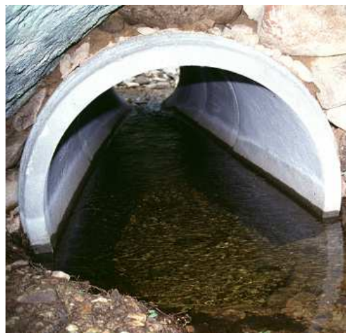
Ouvrage de franchissement bien calé
